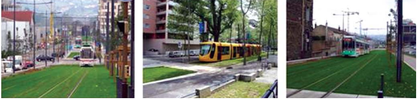
Resim 2. Avrupa kentlerinde yeşillendirilen tramvay geçiş hatları
